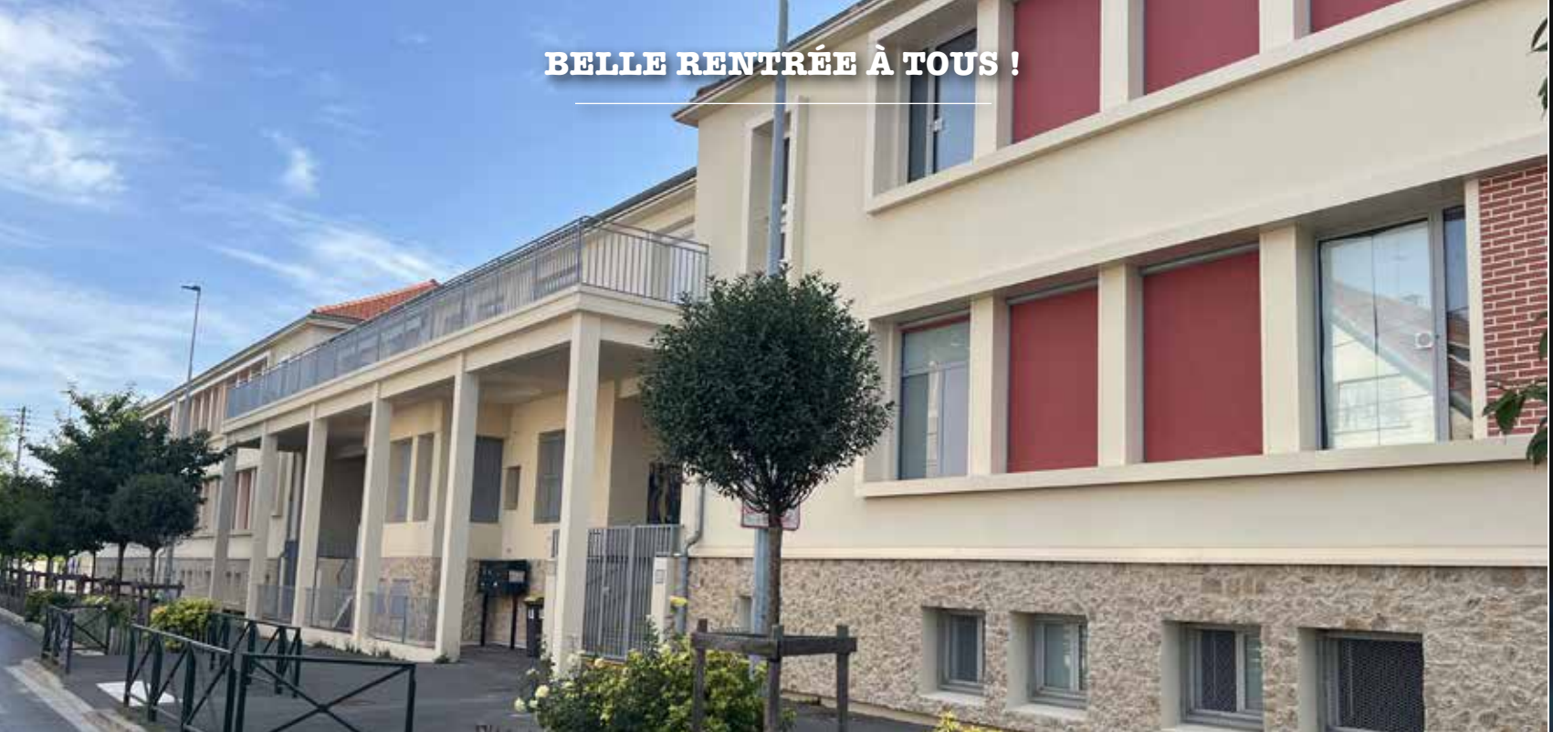
Rénovation thermique du groupe scolaire Louis Pasteur.
