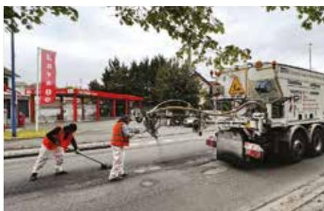
**Afin de prolonger la durée de vie des chaussées chelloises, la Ville fait appel à une technique, le blow-patcher, qui permet de réparer en un temps record les nids de poule et autres dégradations de voirie.**
