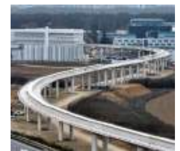
Le viaduc de la ligne 18 à Palaiseau
