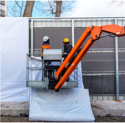
Installation des bâches acoustiques.
