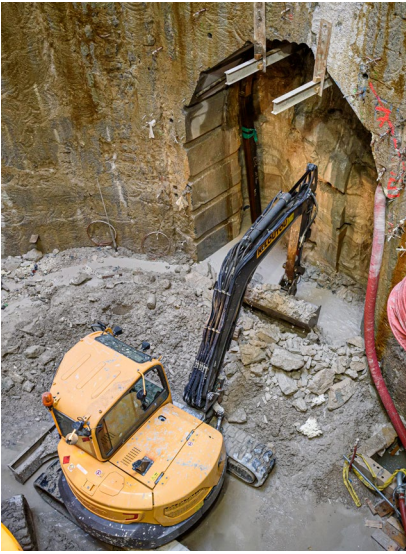
Construction d'un rameau.
