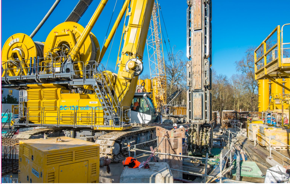
A l'aide d'une benne mécanique, les compagnons forment les panneaux dans lesquels ils couleront ensuite du béton, jusqu'à 62 m de profondeur.
