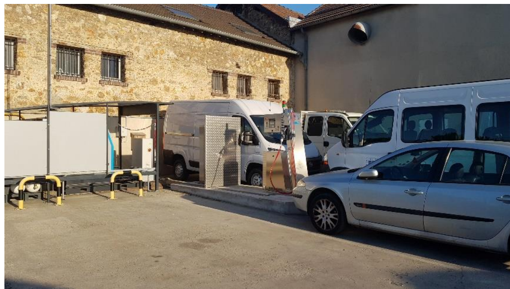
Vue 17 : station-service au gaz – zone de stationnement
