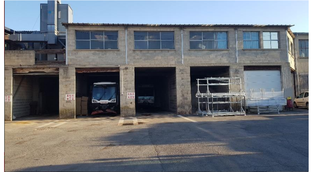
Vue 23 : zone de stockage de sel
