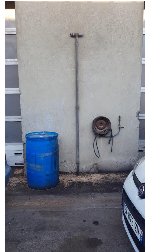
Vue 10 : évent cuve d'huiles usagées
