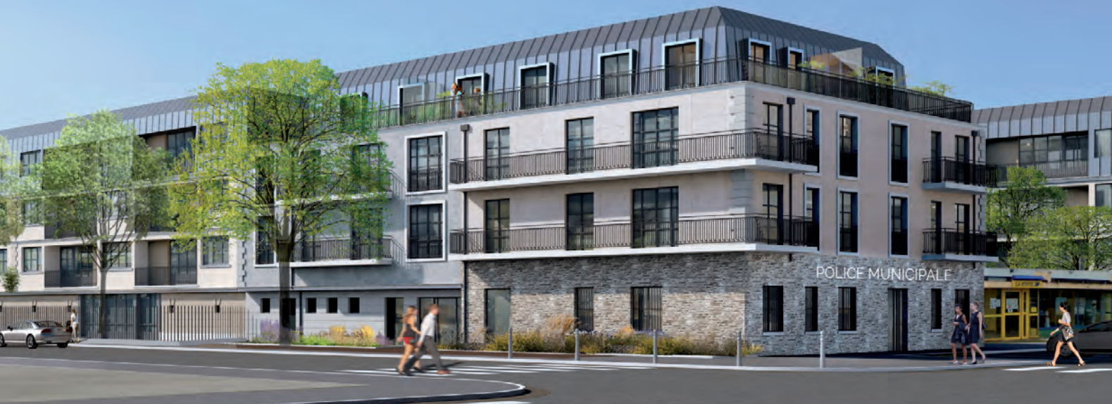
Le Poste de Police municipale des Coudreaux, au rez-de-chaussée de la résidence Gay-Lussac
