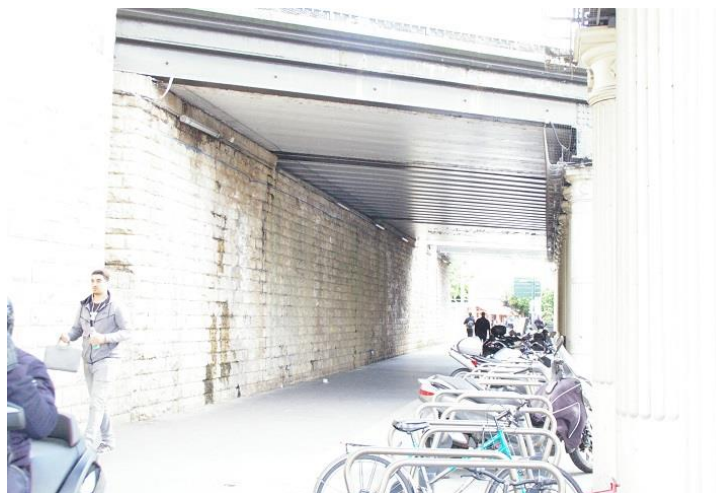
FIGURE 6 - PASSAGE SOUS LE PONT SNCF FOCH-RESISTANCE
