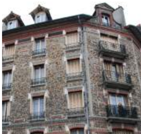
Façade d'immeuble, avenue de la Résistance
