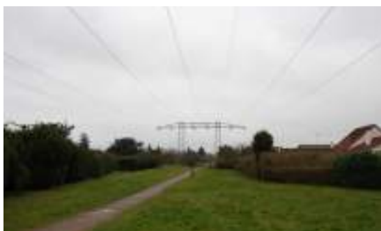
Sente paysagée sous une ligne électrique
