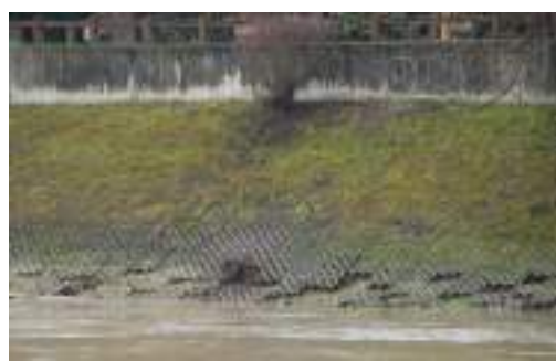
Dalles alvéolées en béton des berges
