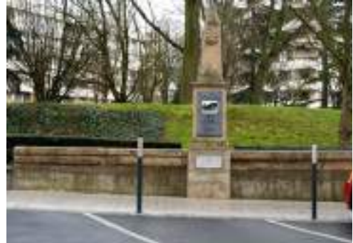
Parapet de l'ancien pont du Ru de Chelles
