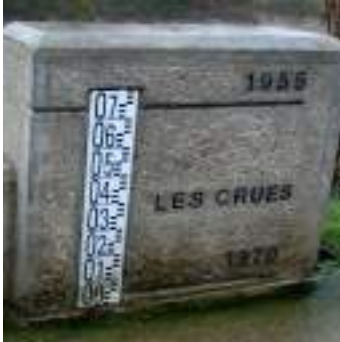
Echelle des crues de La Marne
