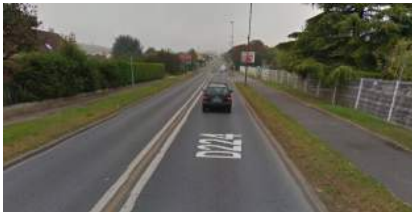
Route départementale n°224 (source : Google Maps)
