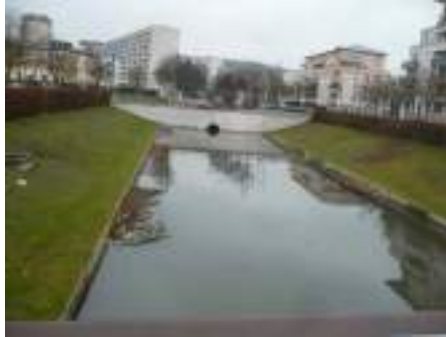
Bassin aménagé sur le ruisseau de Chelles (source : erea-conseil)
