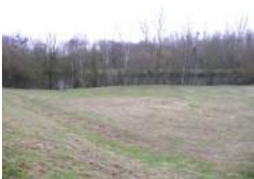
Bassin de rétention au Nord (hors périmètre)
