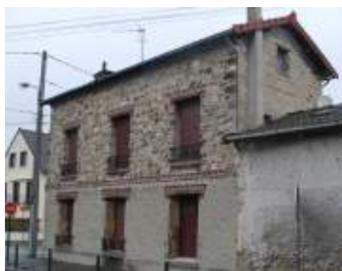
Maison de ville étroite dans le Centre
